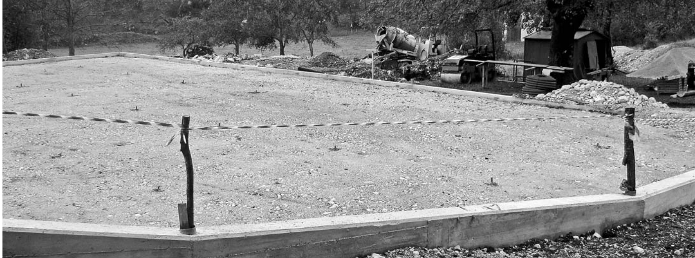
Izgradnja igrišča v Magozdu. Foto: arhiv Občine Kobarid
